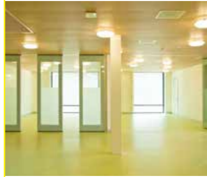
BEWEGLICHE SCHALLDÄMMENDE PANEELWAND AUS GLAS
